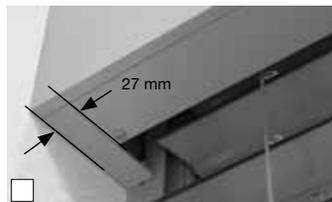
Im Element sind beidseitig feststehende Kastenteile verbaut die bei der Einputzvariante auch als Friese dienen.
